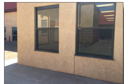
Replace exterior windows
