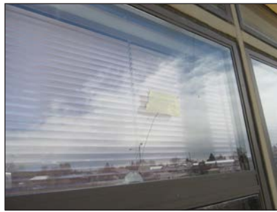
Replace exterior windows
