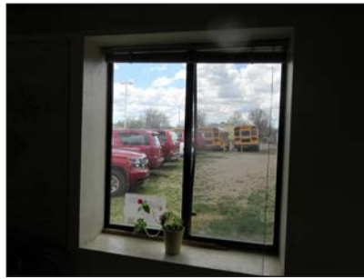
Replace exterior windows
